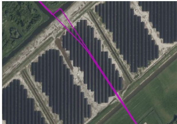
Situatie waarbij een zonneweide boven een AWTL is aangelegd zonder goede maatregelen om de leiding bereikbaar te houden – bron afbeelding: waterschap Aa en Maas.
