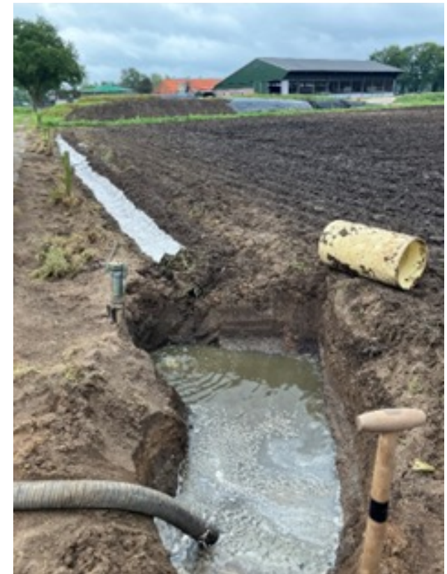
Ontluchter van een AWTL is geraakt bij landbewerking – bron afbeelding: waterschap Rijn en IJssel.
