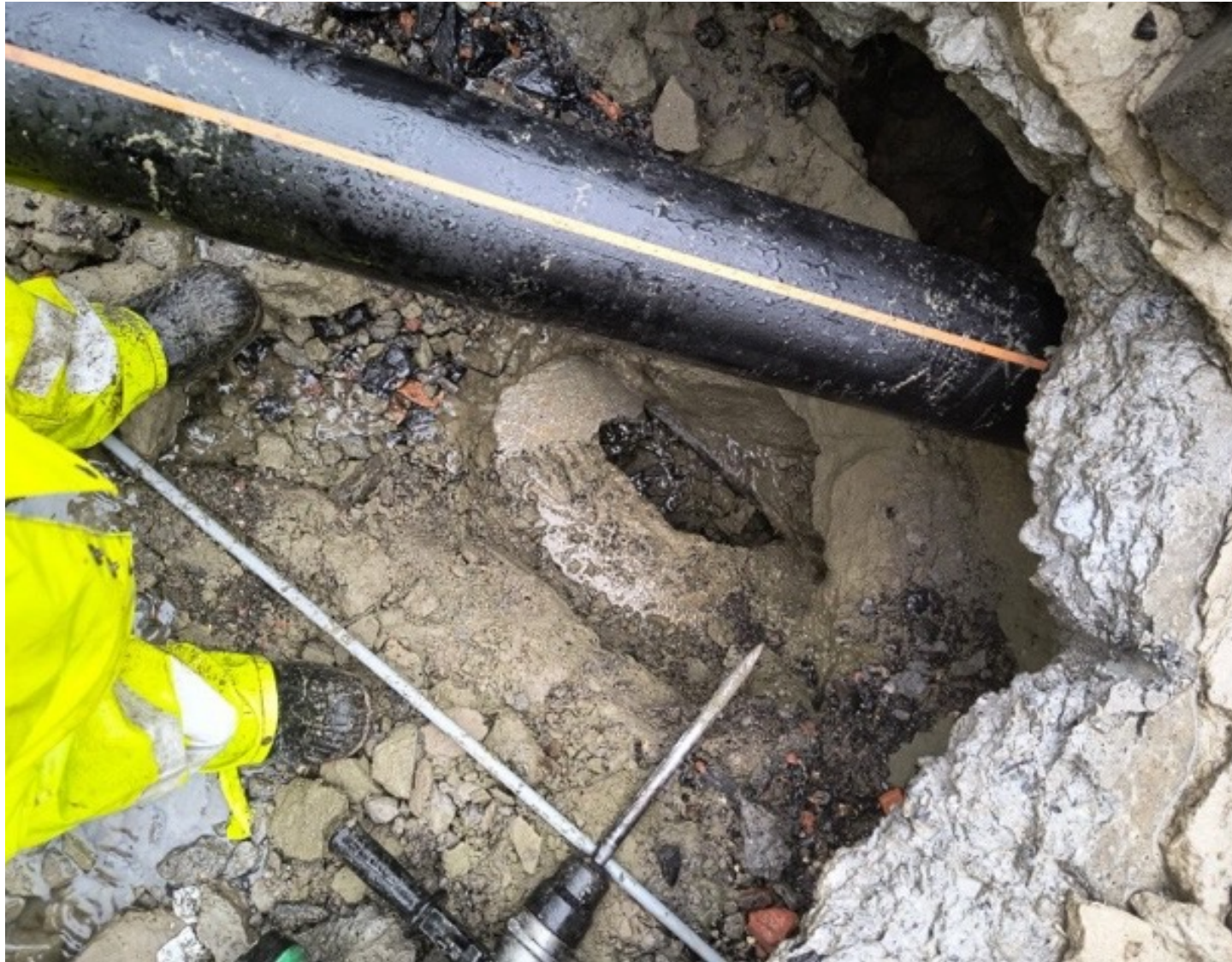
Bij het uitvoeren van een gestuurde boring is dwars door een AWTL geboord - Bron: Aquafin.
