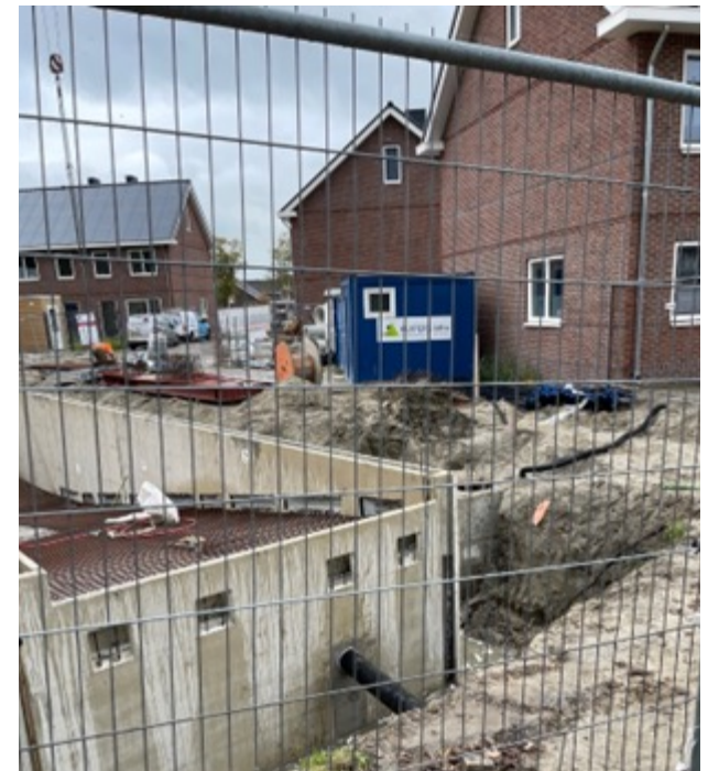
Bouw van een parkeergarage waarbij een raakvlak ontstond met een AWTL en onvoldoende tijd was om deze vooraf te verleggen – bron afbeelding: waterschap Hollandse Delta.
